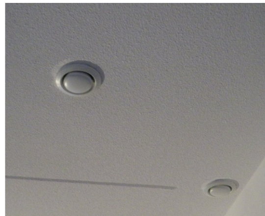
Afbeelding 13 Foto's van de roosters in kozijnen en van ventielen in het plafond
