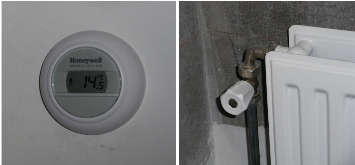
Afbeelding 11 Foto's van de bediening en het afgiftesysteem
