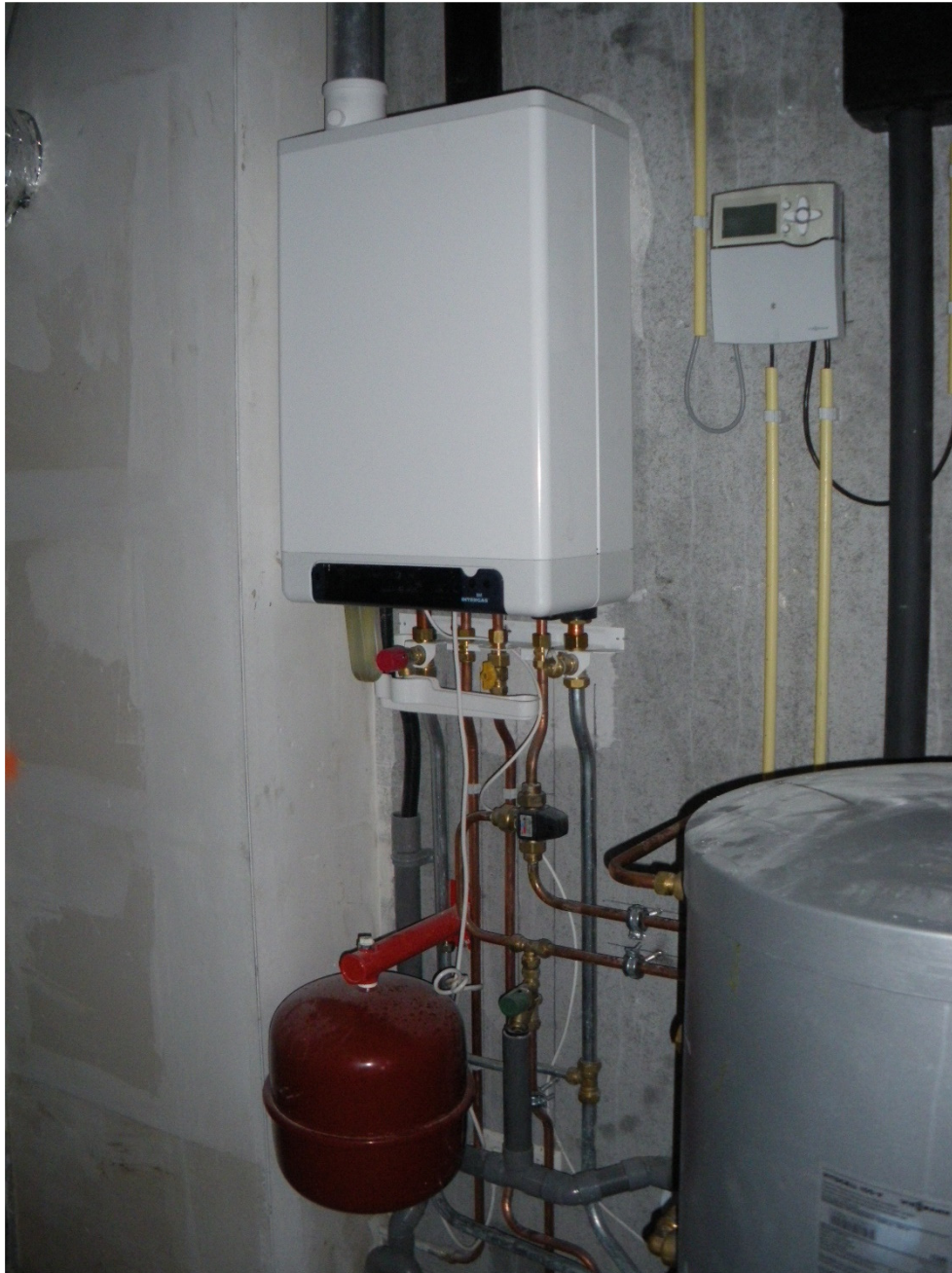
Afbeelding 8 Foto van de warmteopwekker
