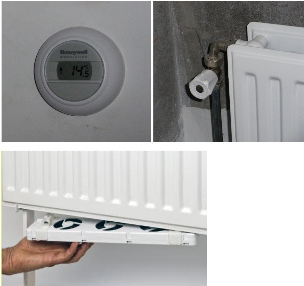
Afbeelding 11 Foto's van de bediening en het afgiftesysteem
