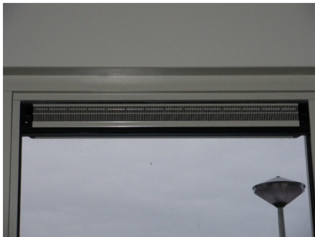
Afbeelding 13 Foto's van de roosters in kozijnen en van ventielen in het plafond
